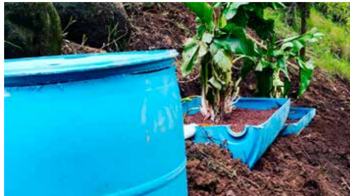
BIOFILTRO: Jardinería que limpia las aguas grises para reciclarlas.
